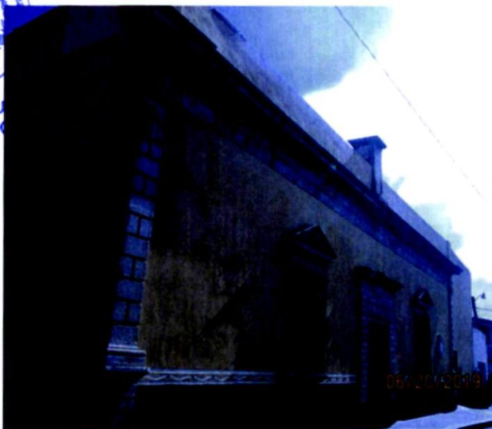
en el marco y en la base de los vanos como si fuese un zoclo. El conjunto se corona con un frontón triangular. La fachada remata con un entablamento. Al centro se observa un elemento de cantería de frente liso, el cual quizás fue colocado para mencionar la fecha de su construcción
