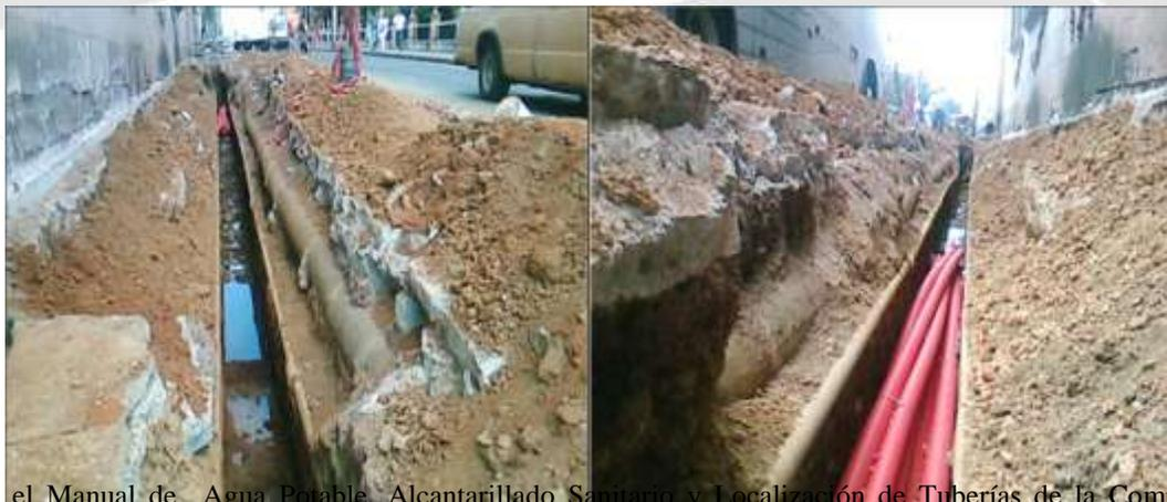
Según el Manual de Agua Potable, Alcantarillado Sanitario y Localización de Tuberías de la Comisión Nacional del Agua, en todos los casos, las tuberías de agua potable deben ir por encima de las redes de aguas negras, a una distancia mínima de un metro de manera horizontal y treinta centímetros de manera vertical. No se permite por ningún motivo, el contacto o cercanía con líneas de gas L.P, redes eléctricas, poliductos, fibras ópticas, cables u otras.
